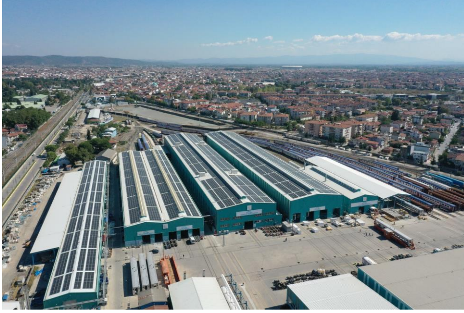
Sakarya Çatı Tipi Güneş Enerji Santrali
