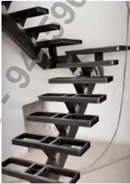
Resim 5. Örnek rıht taşıyıcılar - ferforje merdiven korkuluğu
