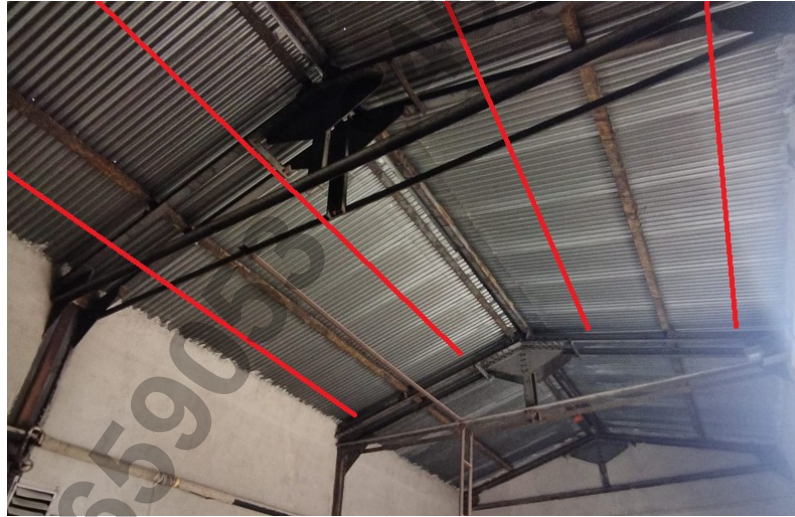
Resim 6. Çatı Konstrüksiyonuna ilave edilecek profiller
